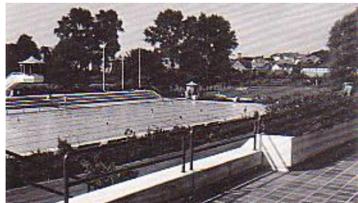
16. Juni 1983 wurde das Freibad für den Badebetrieb freigegeben
